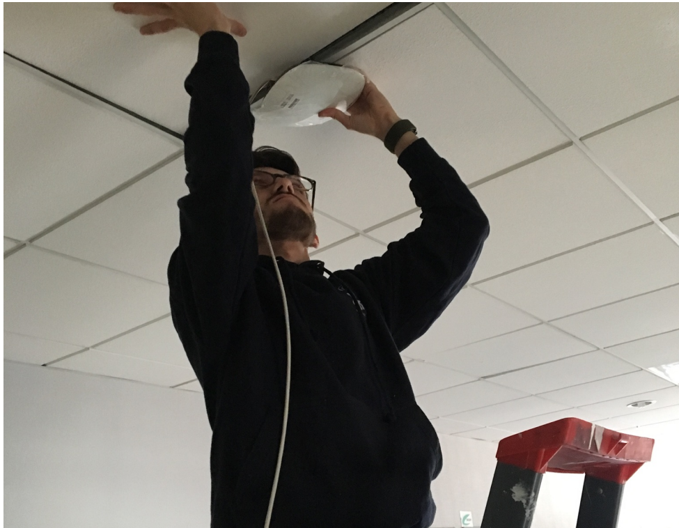
Figure 19 : Pose d'un point d'accès sans fil
